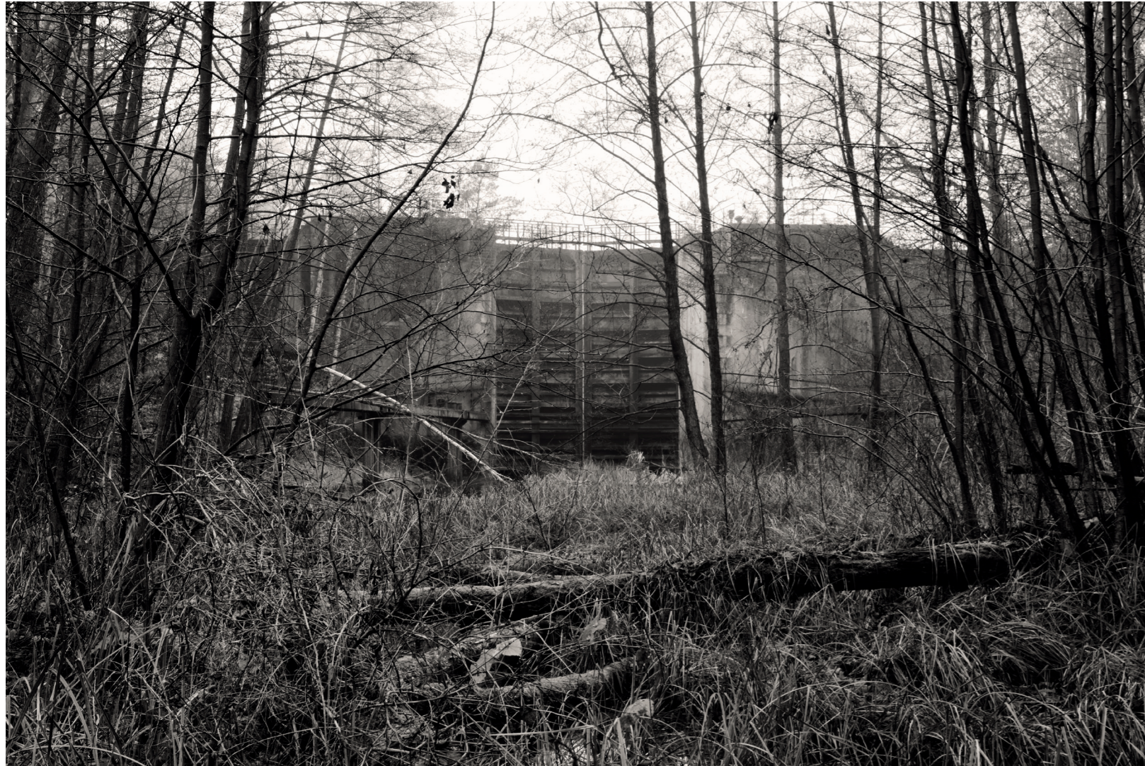
Das Ende des Finowkanals: Unterhaupt von Schleuse 1 der Niederfinower Schleusentreppe, 2019.
