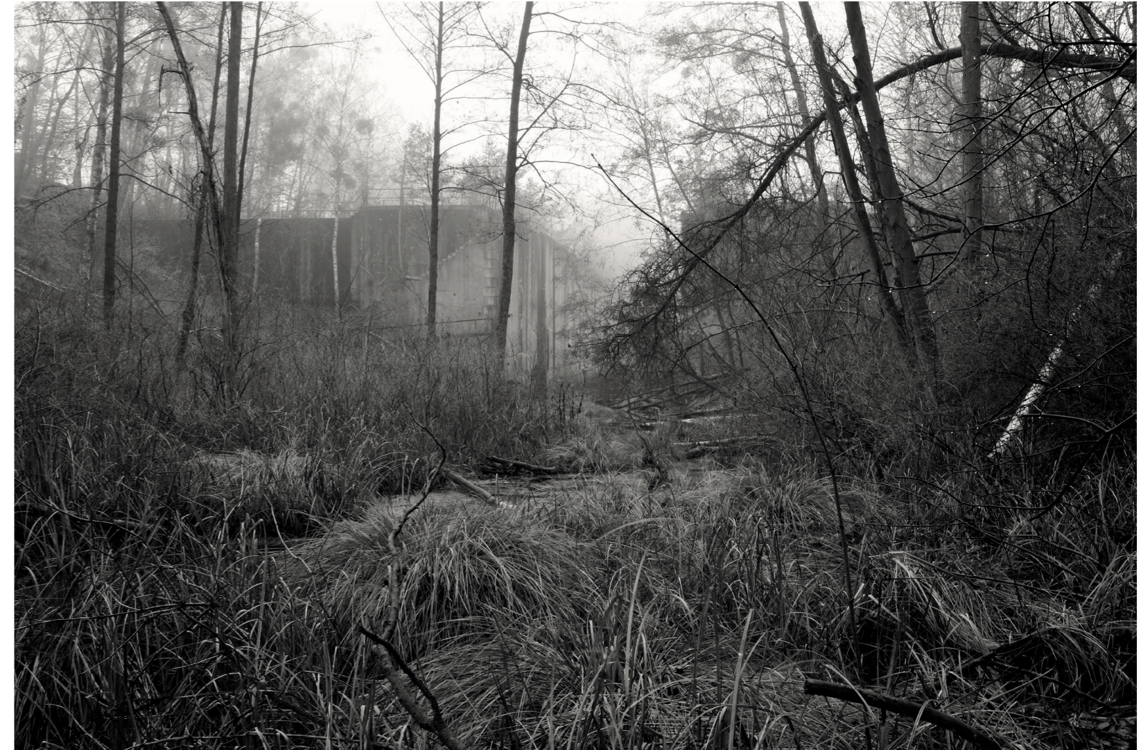
Das Ende des Finowkanals: Unterhaupt von Schleuse 2 der Niederfinower Schleusentreppe, 2019.
